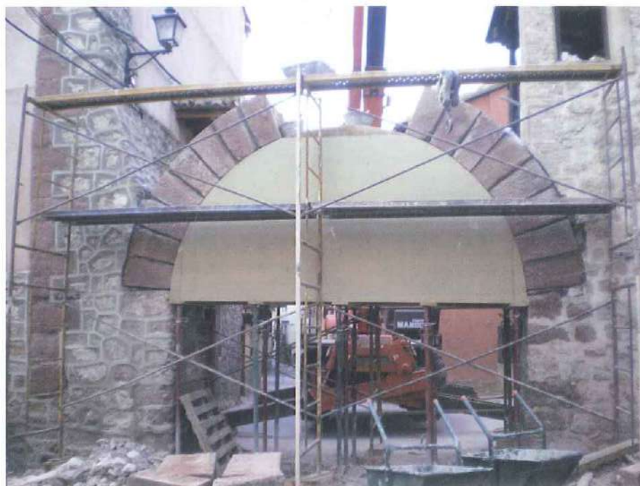
“ RECONSTRUCCIÓN ARCO EN GEA DE ALBARRACÍN – AÑO 2010”
